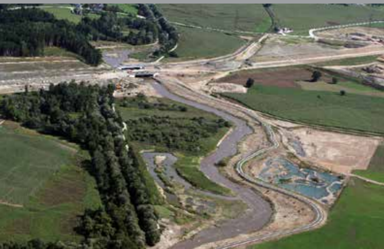
Der im Zuge der ÖBB-Maßnahme „Bahnhof Lavanttal“ neu angelegte Verlauf der Lavant bei Aich dient als Vorbild für weitere 400 m Laufverlegung im Life Projekt Lavant (Foto: ÖBB)
