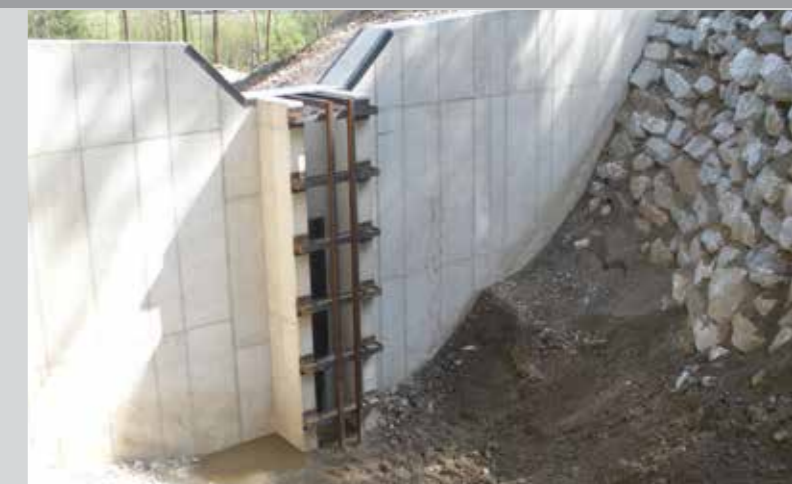
Die Baumaßnahmen kurz vor Fertigstellung ▲
