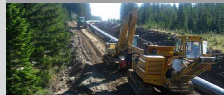
UVE Tauerngasleitung (Bildbeispiel: Bau der Trans-Austria-Gasleitung)
